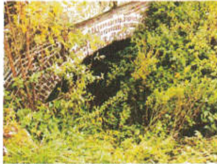
Végétation à l'aval de l'ouvrage
