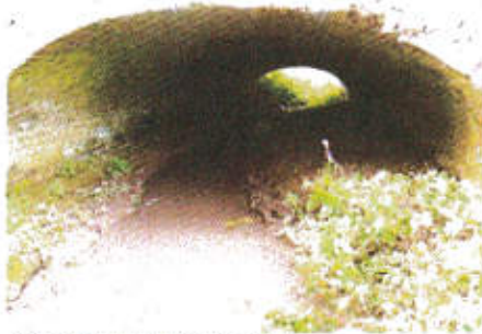
Atterrissage vue de l'amont
